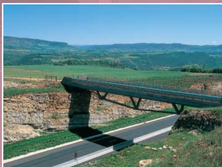
Pont du Truc de la Fare (ouvrage sous-bandé), sur l'A 75
