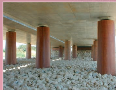
Un ouvrage d'art de la section Boucoiran – La Calmette de la RN 106, entre Nîmes et Alès
