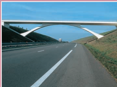
Ouvrage en arc, sur l'A 83, commune de Saint-Vincent Puymaufrais
