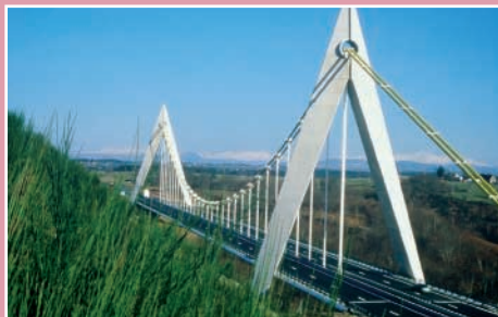
Viaduc du Chavanon, sur l'A 89
