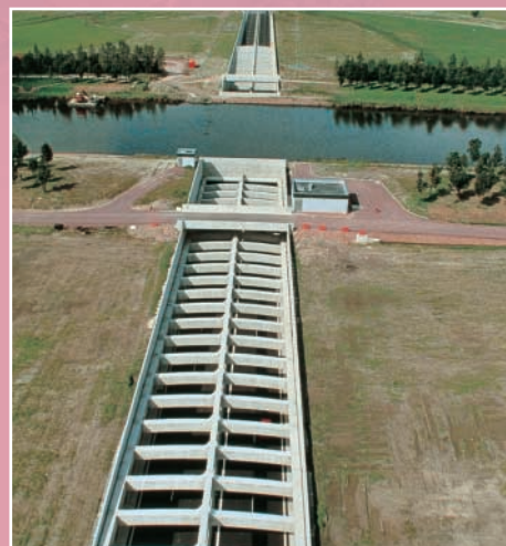
Pont canal à Carentan, dans la Manche, sur la RN 13
