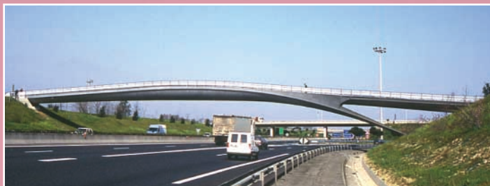
Passerelle PS0 sur la rocade Est de Toulouse
