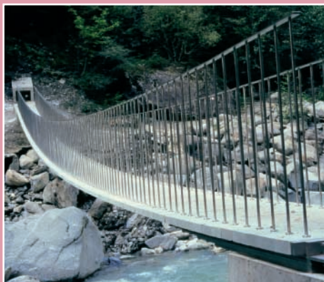
Passerelle "da Suransuns", sur le chemin de la Viamala, près de Thusis, dans les Alpes suisses
