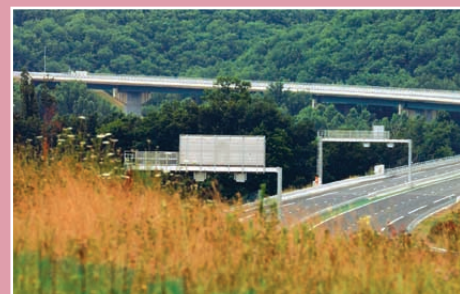
Le Viaduc de la Dordogne, sur l'A 20 Cahors Nord-Souillac
